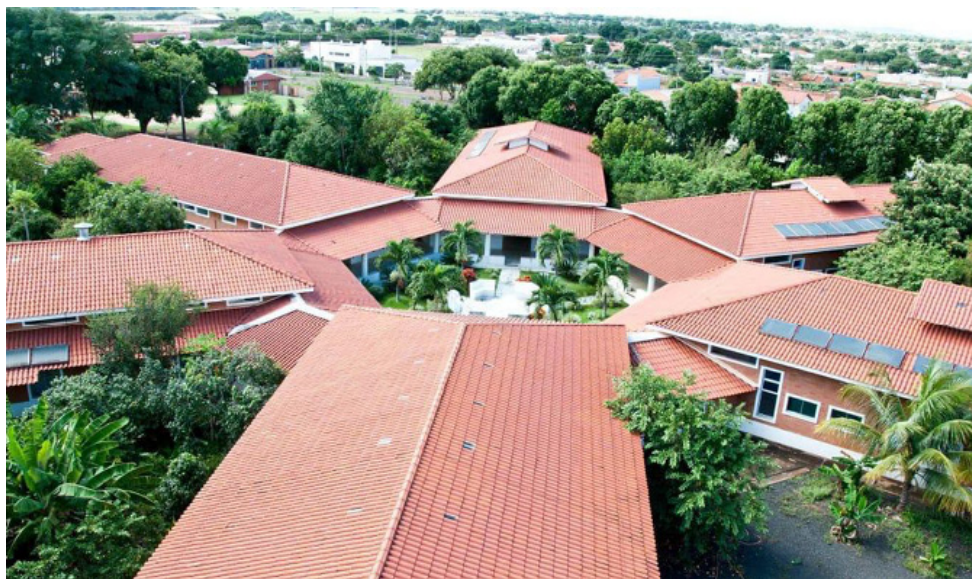
Instalações do antigo Hospital do Câncer em Goiatuba, atual Universidade do Cerrado. Foto: acervo pessoal do autor.
